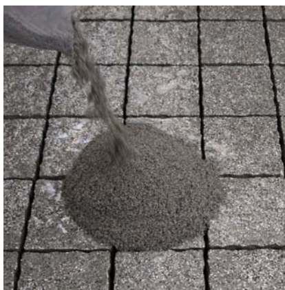
Następnie rozciąć próżniowo zamknięty worek z tworzywa sztucznego i wysypać zaprawę na powierzchnię bruku.
