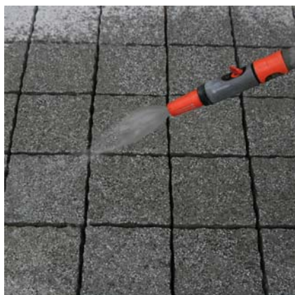
Przed aplikacją PCI Pavifix® 1K Extra powierzchnię kostki brukowej i należy obficie zwilżyć wodą. należy obficie zwilżyć wodą.
