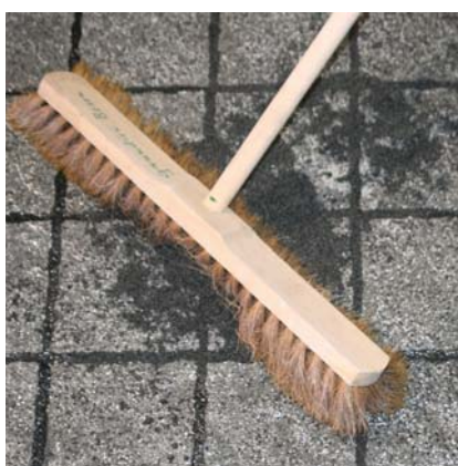
Resztki zaprawy pozostałe na powierzchni zamieść miękką miotłą ukośnie do przebiegu spoin.
