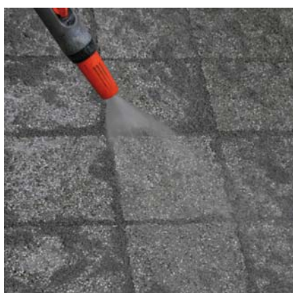
W przypadku spoin od 3 do 8 mm przepłukać powierzchnię lekkim strumieniem wody wzdłuż spoin z jednoczesnym szlamowaniem.
