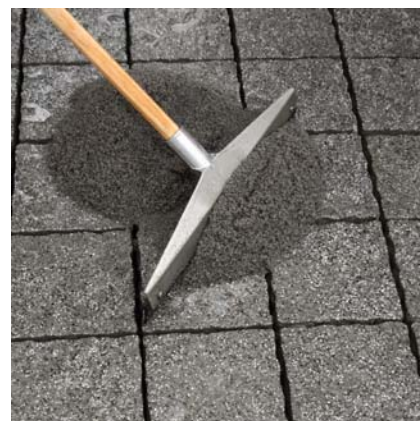
Rozprowadzić rakłą gumową wprowadzając materiał na całą głębokość w spoiny i zagęszczając.
