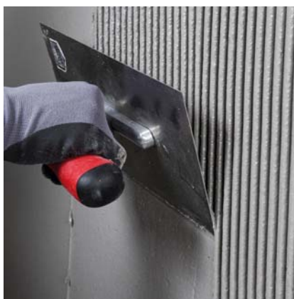
Wyrównanie ostatniej warstwy pomaga uzyskać gładką strukturę.
