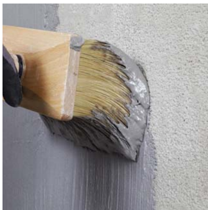
Warstwa kontaktowa nakładana pędzlem.
