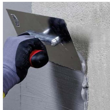
Warstwa kontaktowa wykonywana w formie tzw. szpachlowania drapanego.
