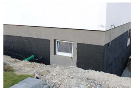
Uszczelnienie strefy cokołowej budynku przy zastosowaniu PCI Barraseal® Turbo przy izolacji podziemnej części budynku wykonanej z masy bitumicznej.
