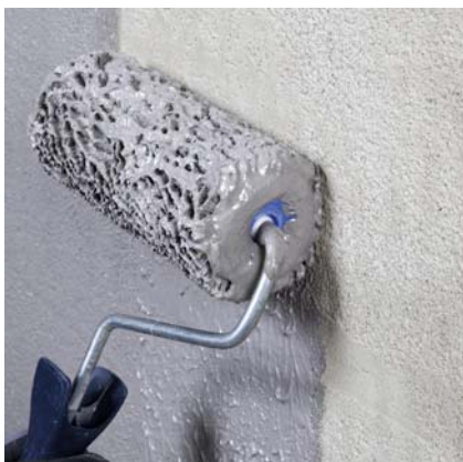
Warstwa kontaktowa nakładana wałkiem
