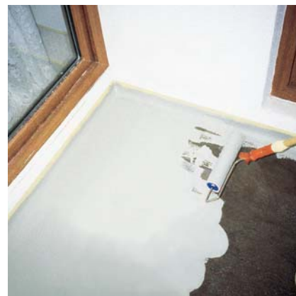
Przespachlowanie zaprawą na bazie PCI PUR-Grund chroni powłokę przed powstaniem pęcherzy i zapewnia jej doskonałą przyczepność do podłoża.
