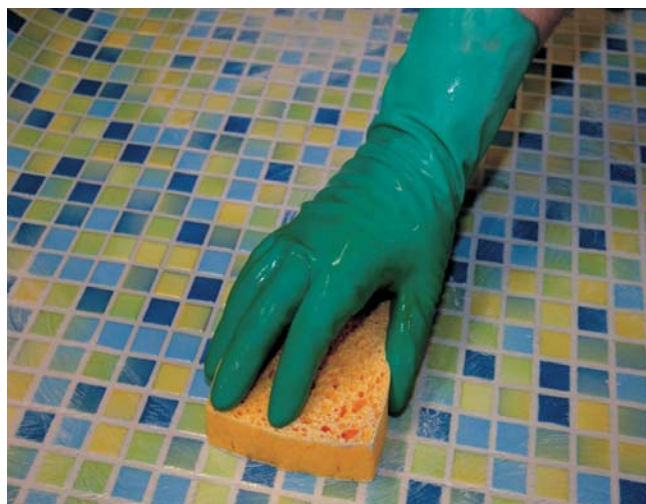
Zmywanie zaspoινωνanych okładzin za pomocą PCI Epoxi-Schwamm fein
