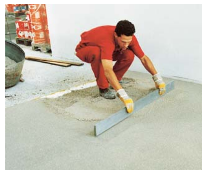
Wykonywanie wysoce odpornego na ścieranie i chemooodpornego jastrychu przemysłowego na bazie PCI Bauharz.
